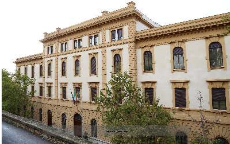
Palazzo della Banca Sicana Luogo dell'identità e della memoria (L.I.M.) di Gino Morici Via Francesco Crispi, 25 - Caltanissetta
